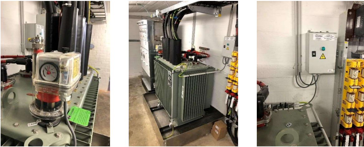
Figuur 18: Sensoren ter bescherming van de transformatoren
