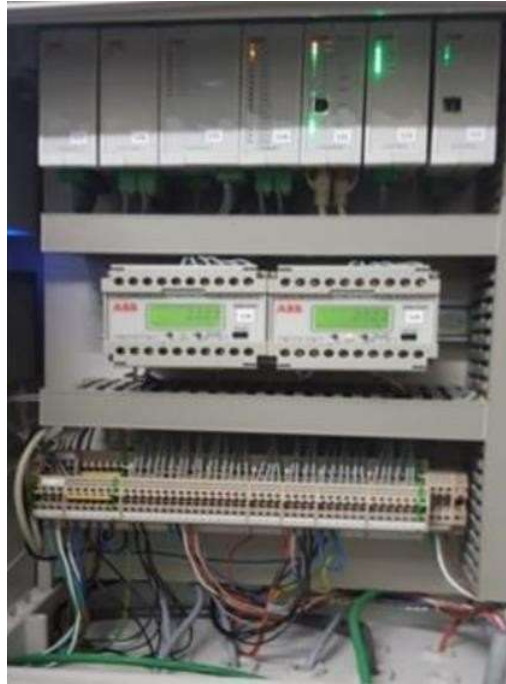
Figuur 17: Telecontrolekast gebruikt in de smart cabines van Sibelga en in de HS-cabines van klanten met een productie \geq 1 MVA
