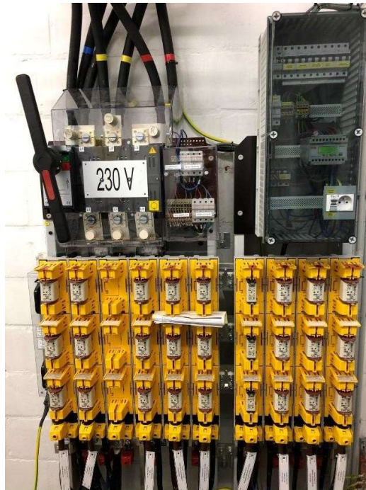
Figuur 19: Algemeen laagspanningsbord (ALSB) in een netcabine van Sibelga
