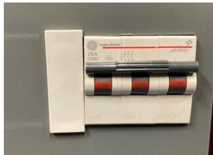
Il n'est pas nécessaire de passer à l'étape 2 pour déterminer le type de raccordement, l'URD ne pouvant être raccordé dans cette configuration que sur un réseau triphasé 3\*230 Vac sans Neutre
